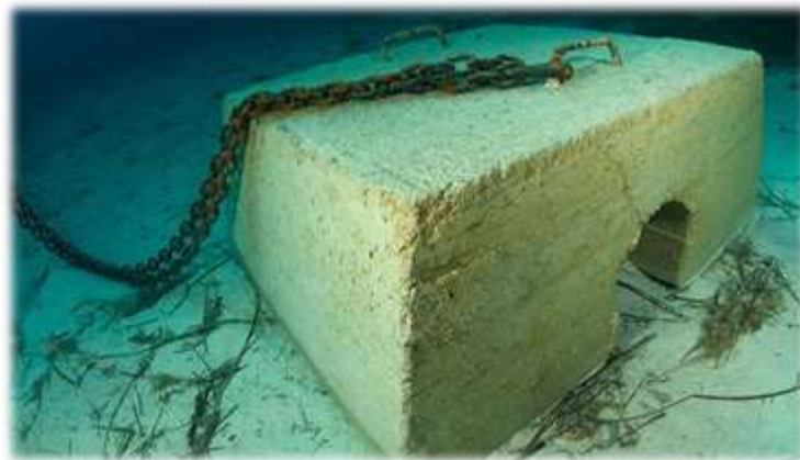
Figura 6. Anclaje de tipo “muerto” de hormigón. Fuente: Diario de Ibiza.es.
