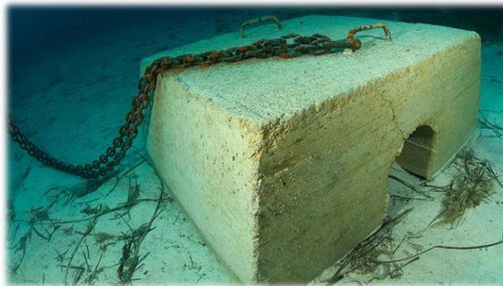
**Figura 7.** Anclaje de tipo “muerto” de hormigón.
