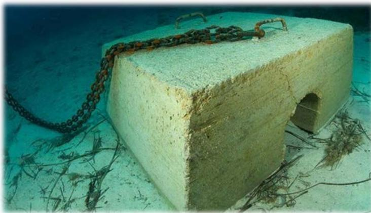
**Figura 6.** Anclaje de tipo “muerto” de hormigón.
