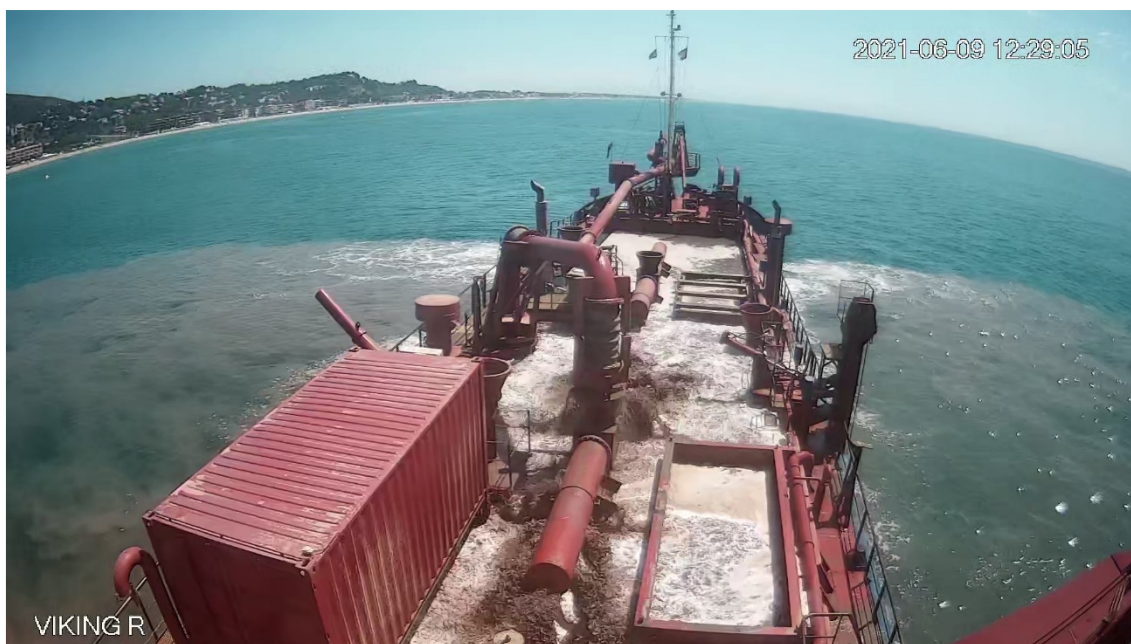
Figura 9. Finos en suspensión llegando a superficie durante el dragado.
