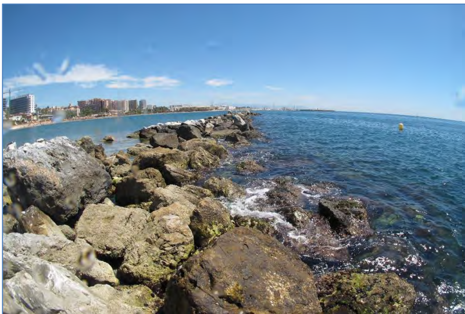
Ilustración 37. Espigón, zona exterior
