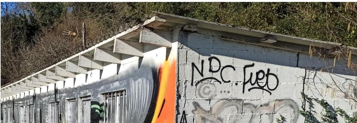
Imagen 4. Detalle de los bloques de hormigón y vigas de madera de las casetas de obra. Fuente: elaboración propia.
