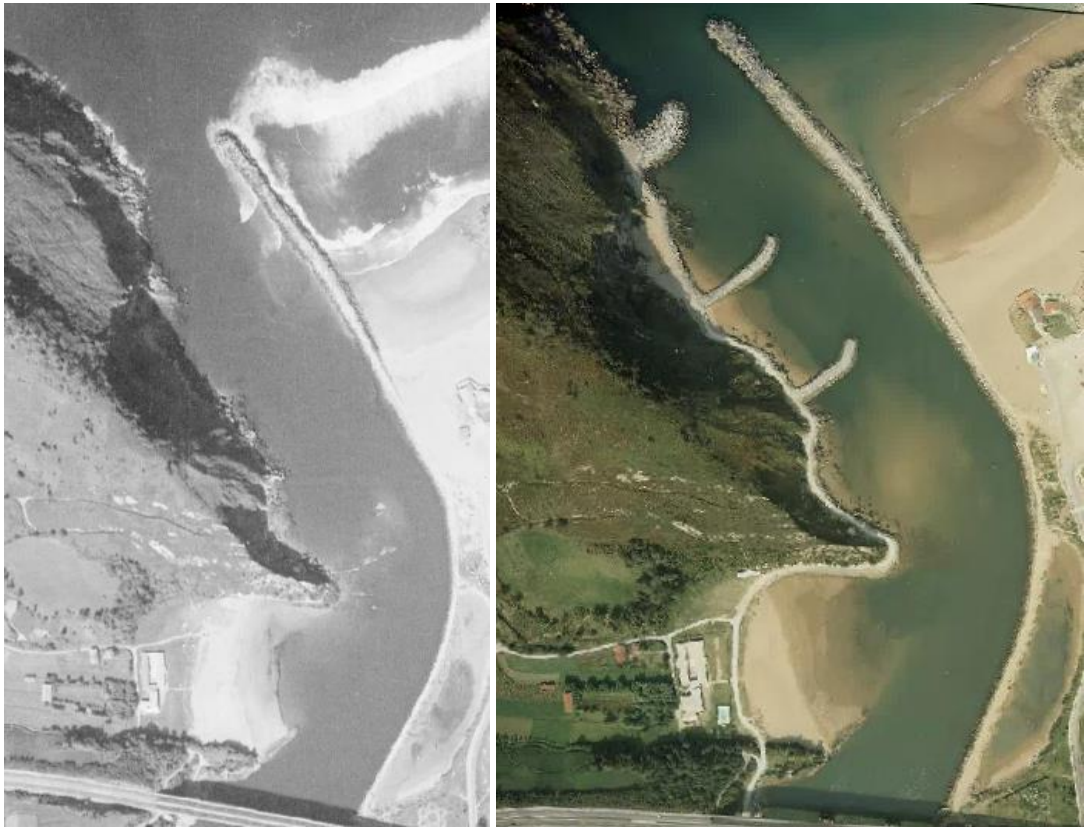
Imagen 24. Vuelo vertical Nacional 1980-1986 de una vista más general (fotografía tomada en octubre de 1984, izq.). Vuelo vertical de Costas 1989-1991 de una vista más general (fotografía tomada en octubre de 1989, dcha.). Fuente: IGN.
