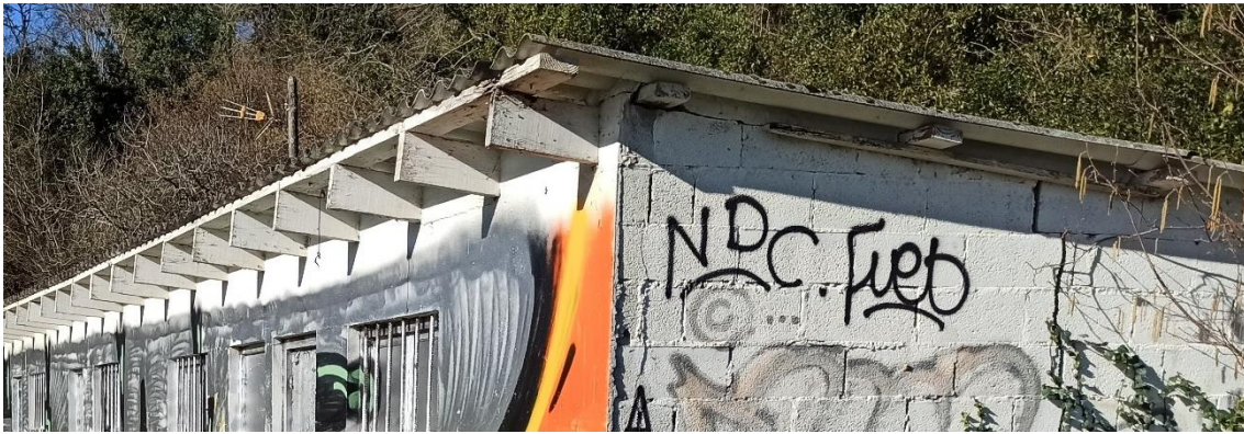
Imagen 44. Detalle de los bloques de hormigón y vigas de madera de las casetas de obra. Fuente: elaboración propia.
