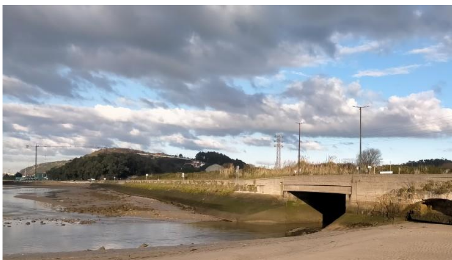
Figura 7: Situación actual de la desembocadura del arroyo Vioño en la Ensenada de Llodero, a través del túnel bajo la carretera AS-239.
