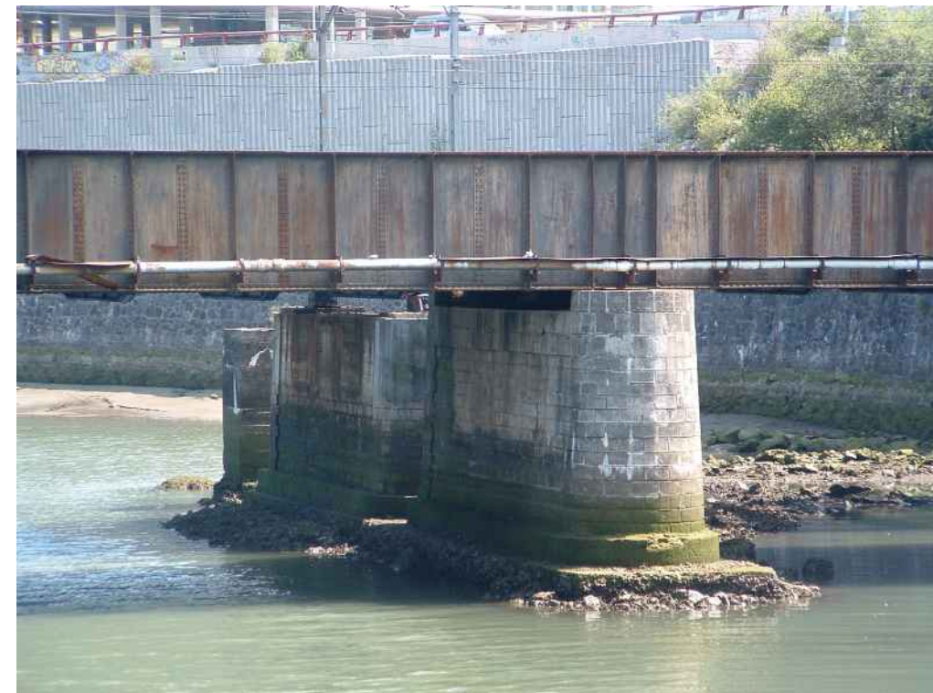
Vista de la pila 2 desde aguas abajo.
