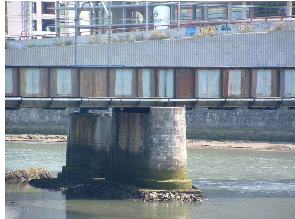
Detalle de la pila 1 del puente.
