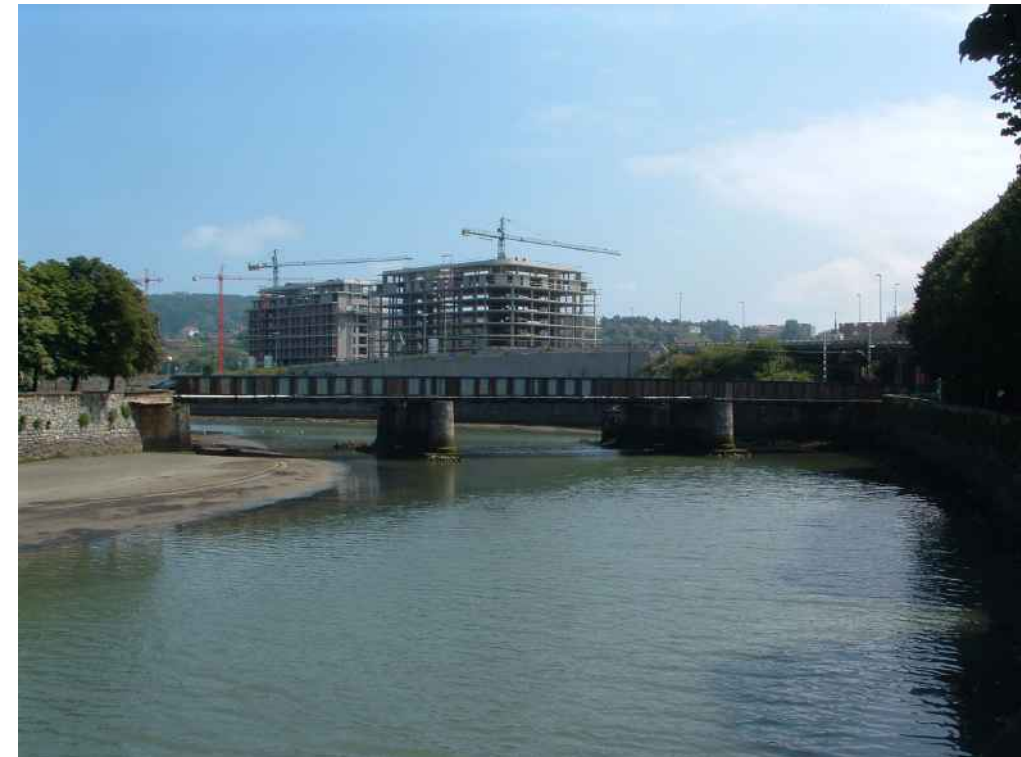
Vista del alzado del puente desde aguas abajo.
