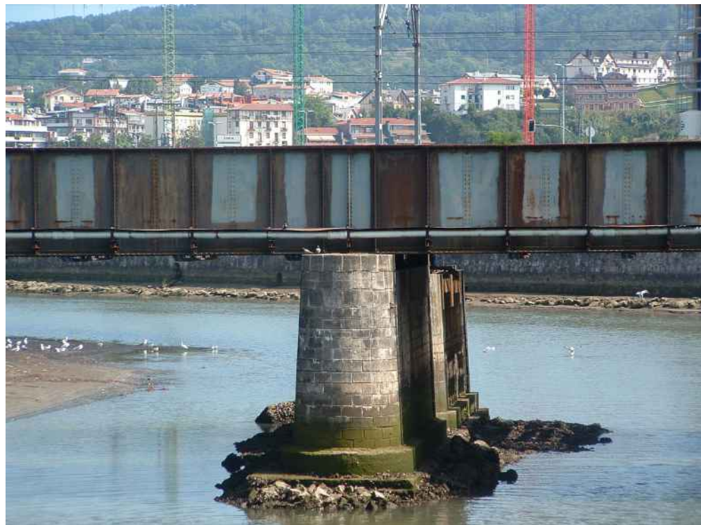
Vista de la pila 1 desde aguas abajo.
