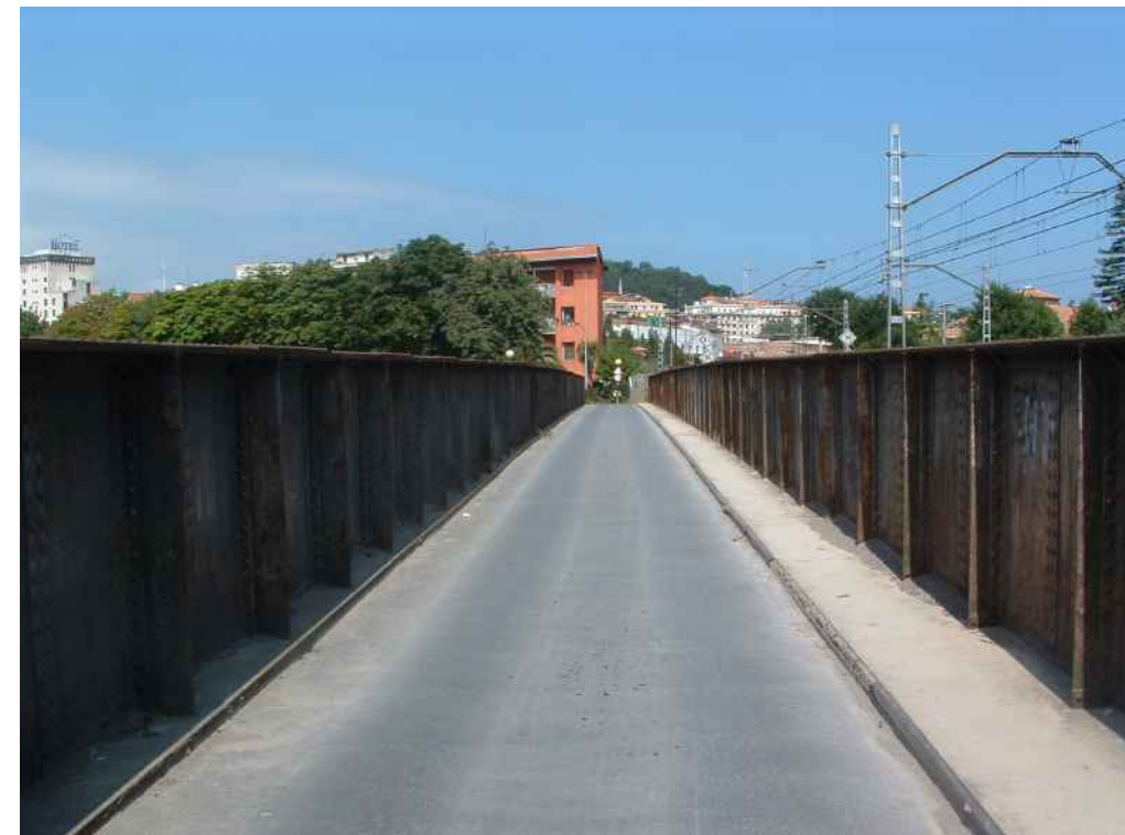
Vista de la sección del puente desde su interior.
