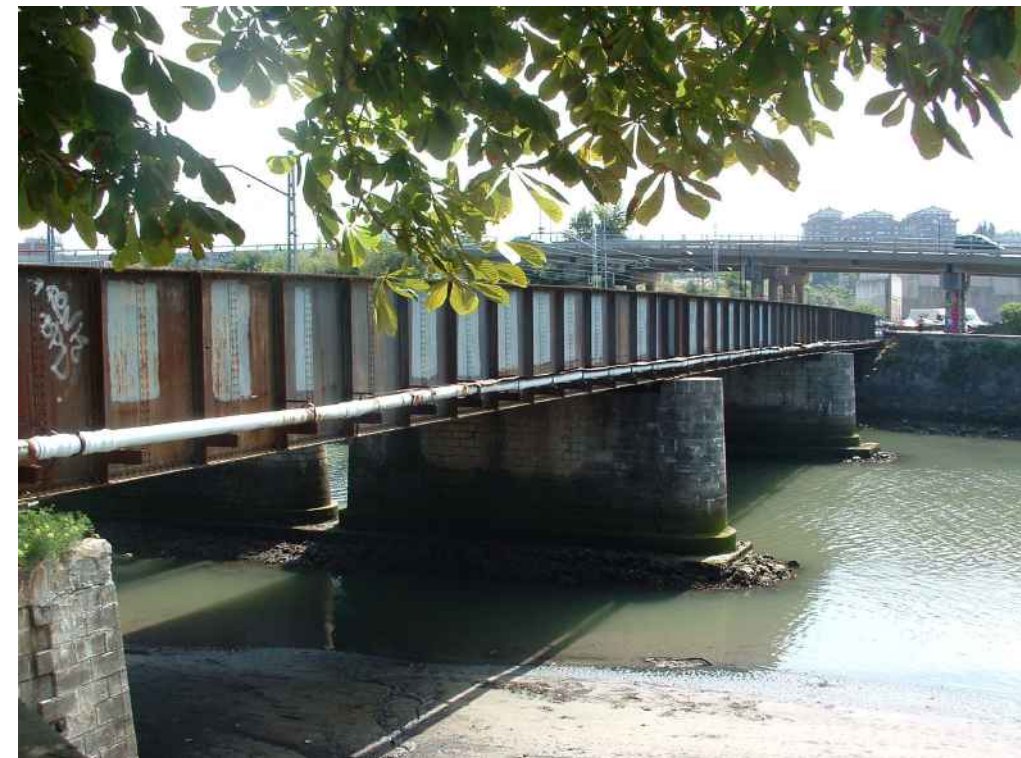
Vista del puente desde la margen derecha desde aguas abajo.
