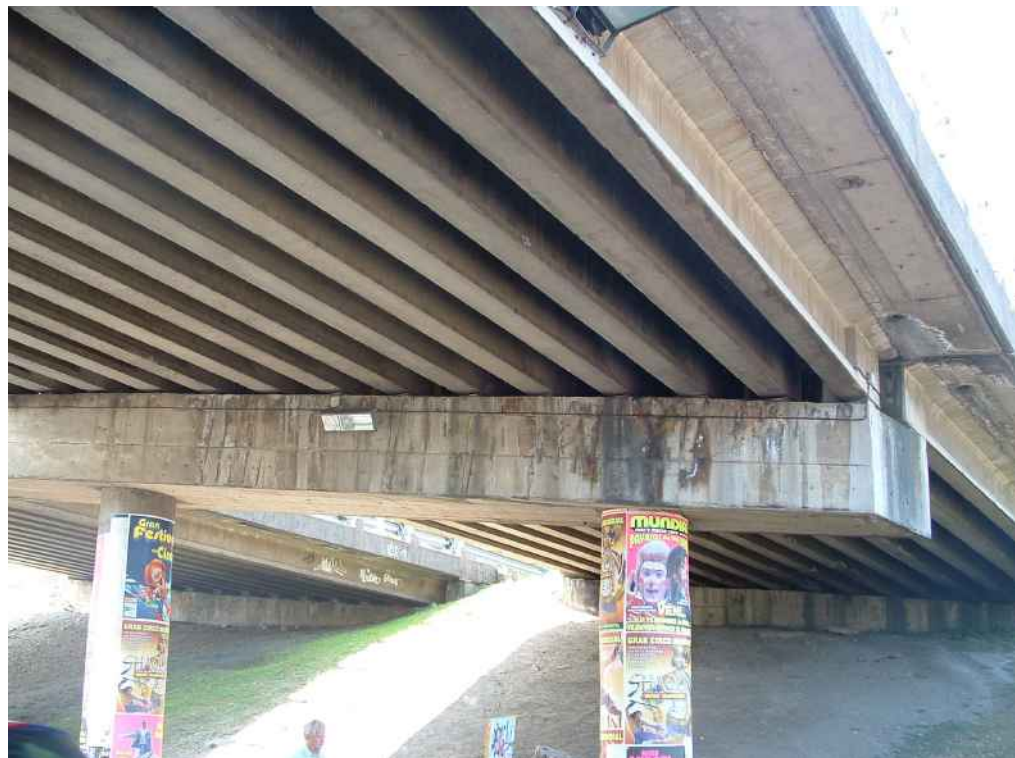
Detalle de la parte inferior del Viaducto de Amara.
