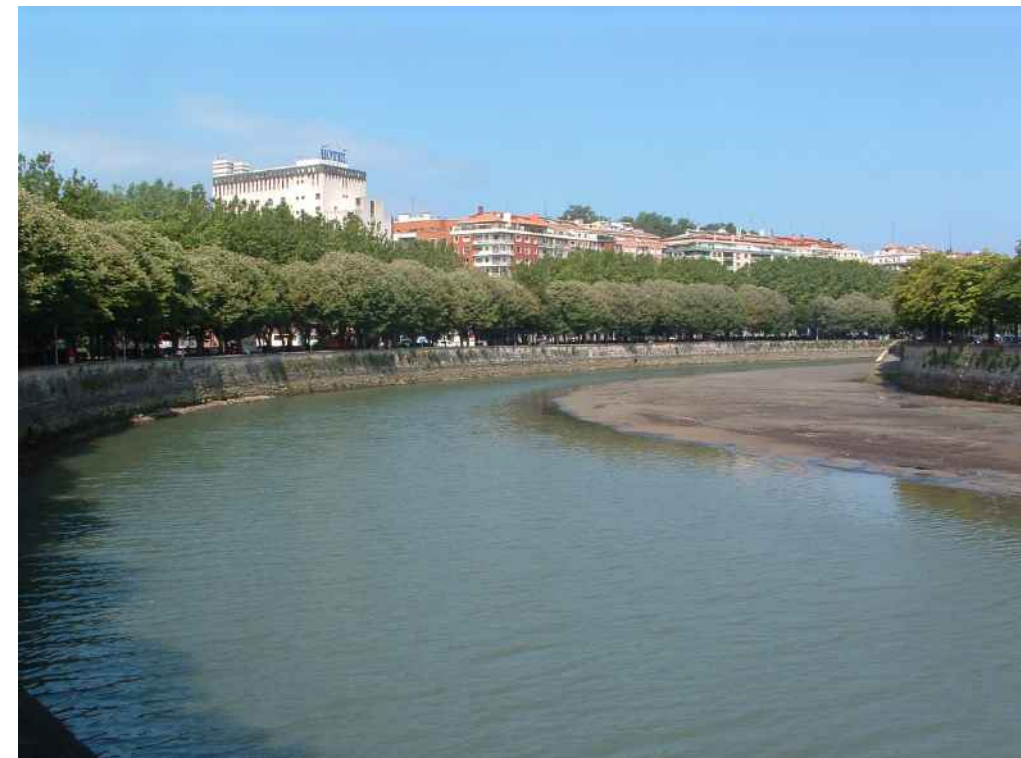
Vista desde el puente hacia aguas abajo.
