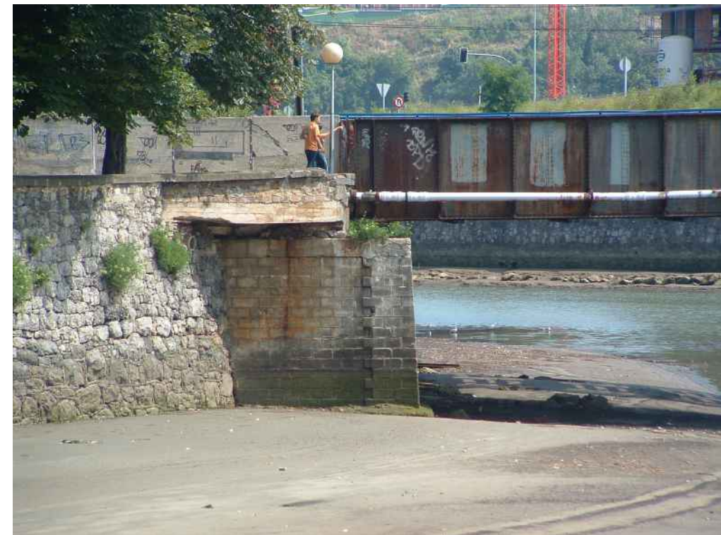
Detalle del estribo derecho del puente.
