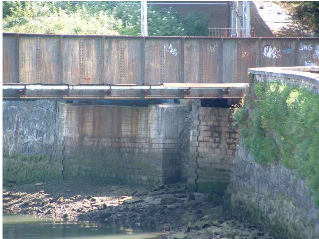
Vista del estribo izquierdo.
