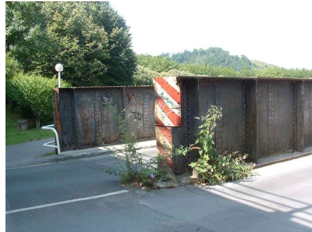
Detalle del acceso al puente.
