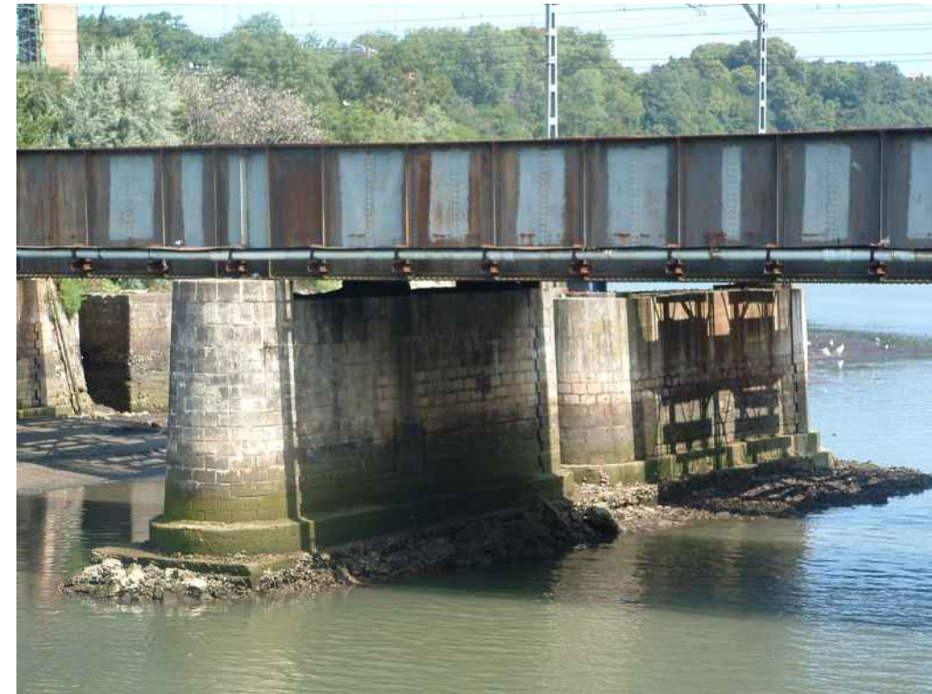
Vista de una pila del puente actual junto a la del puente de ferrocarril.
