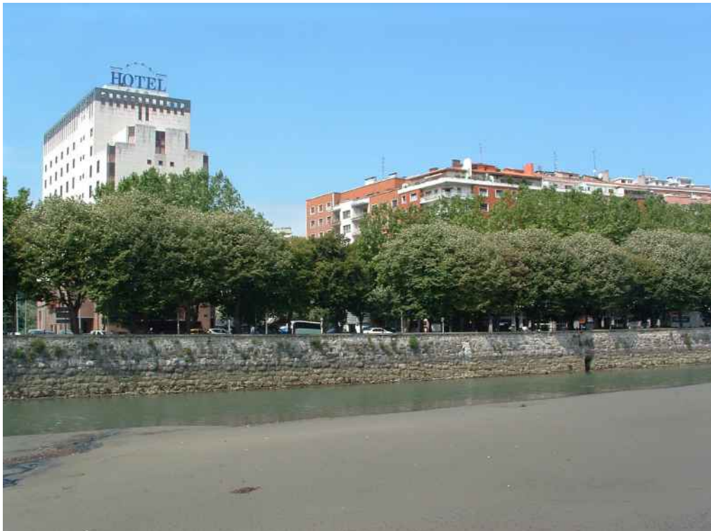
Vista del entorno aguas abajo del puente.
