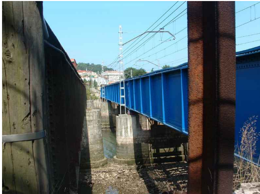
Vista de los dos puentes desde la margen izquierda.
