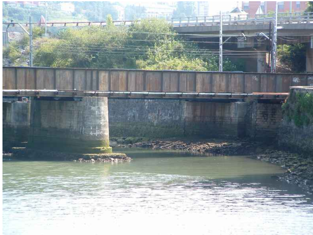
Detalle de la pila 2 del puente y del estribo izquierdo.
