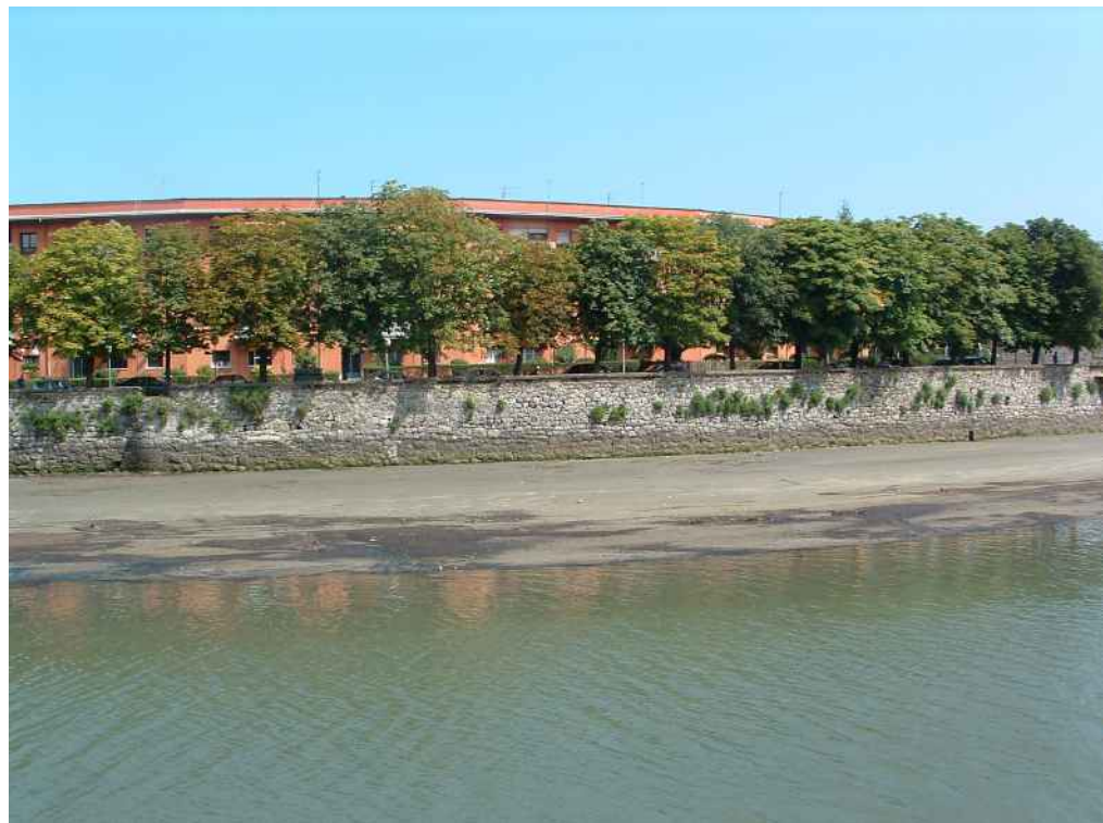
Vista del entorno del puente.
