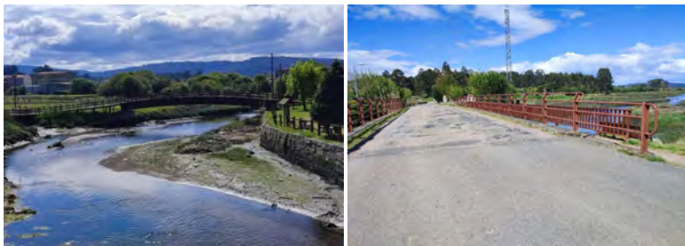
Detalle de los puentes existentes.
