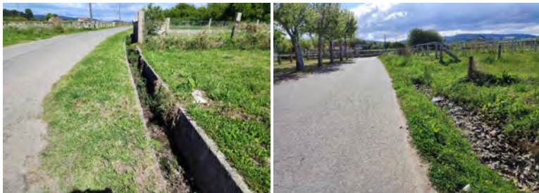
Canales de drenaje y cunetas en tierras.
