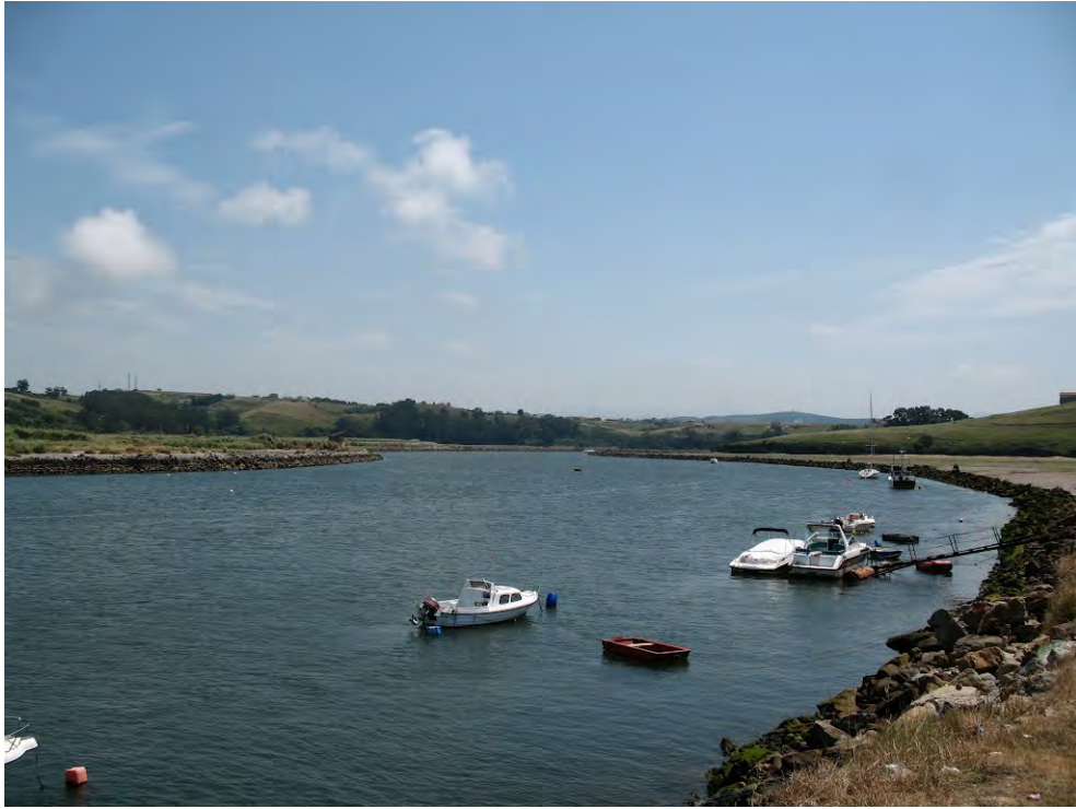
Tramo pk 20: estado actual de la escollera.
