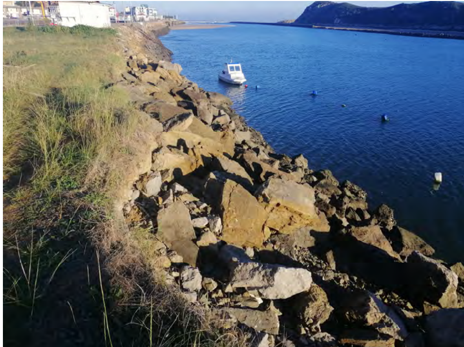
Tramo pk 00: estado actual de la escollera.
