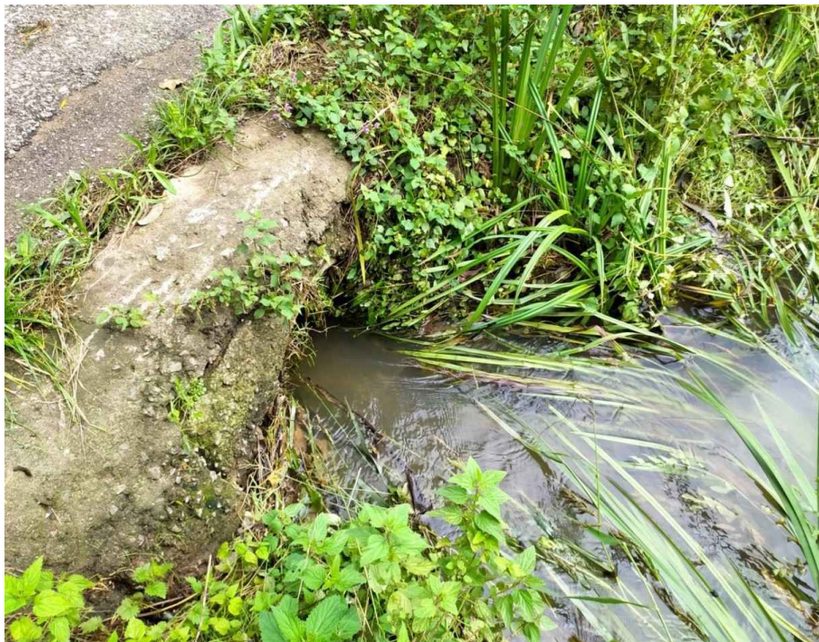
Fotografía 4. Detalle de uno de los caños Ø500 mm.
