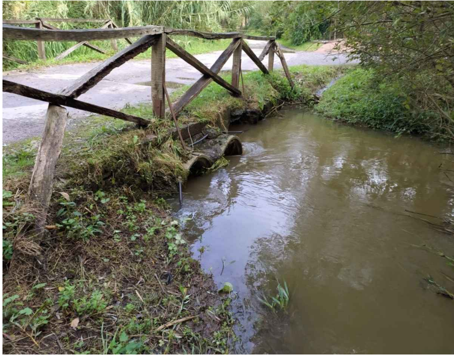
Fotografía 9. Detalle de la entrada de la obra de drenaje principal.
