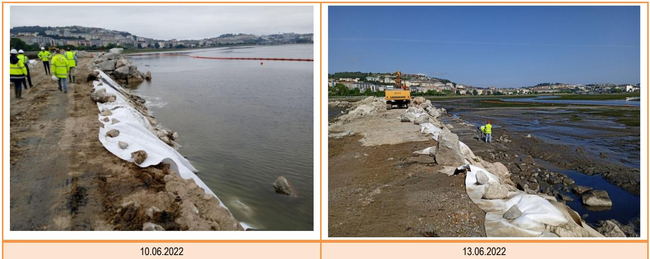
Figura 9 Empleo de geotextil en frente de avance.
