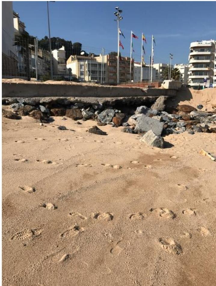
Foto 4. Escollera desplazada por el oleaje y cimentación descalzada
