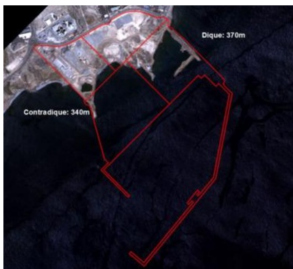
Figura 32. Estado de las obras en el mar del puerto de Granadilla en mayo de 2012 (Fuente: Observatorio Ambiental de Granadilla)
