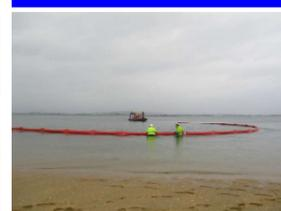
Las barreras se despliegan en el agua con la ayuda de personal especializado y correctamente equipado, y la colaboración de embarcaciones auxiliares.
