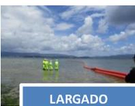
Las barreras se despliegan en el agua con la ayuda de personal especializado y correctamente equipado, y la colaboración de embarcaciones auxiliares.
