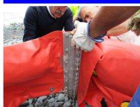
Las barreras se enlazan unas con otras hasta alcanzar la longitud deseada.
