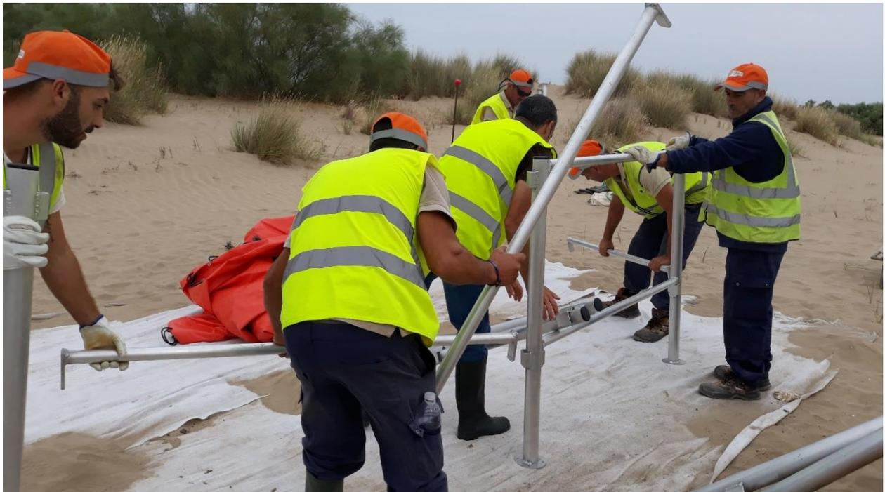
*Ilustración 30. Personal interviniente realizando el despliegue del fast-tank.*
