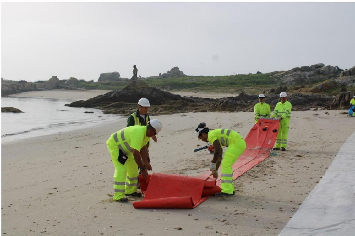
*Ilustración 30. Despliegado de la barrera selladora por personal de TRAGSA.*
