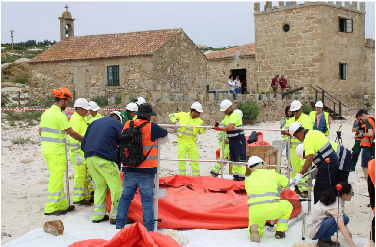
*Ilustración 22. Personal interviniente realizando el montaje de los tanques de almacenamiento.*
