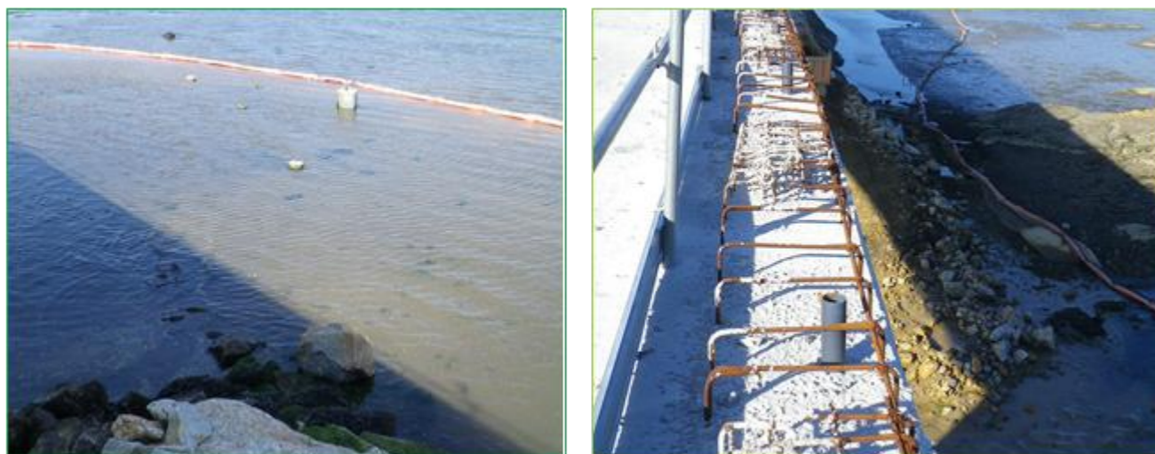
Imagen 64. Disposición de barreras de turbidez (marea baja) y "muertos" de sujeción.
