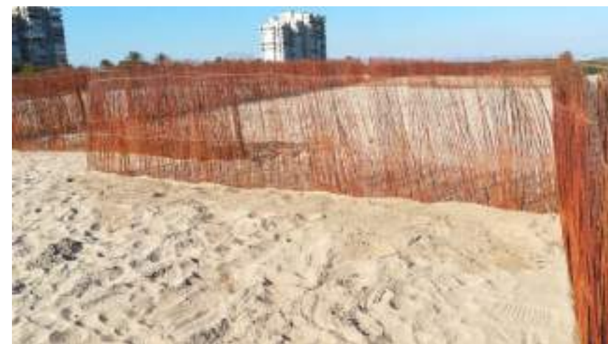
Imagen 83. Detalle de la apertura solapada de las hileras perpendiculares
