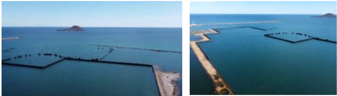
Imagen 1. Tablestacado presente en el interior de la Caleta del Estacio
