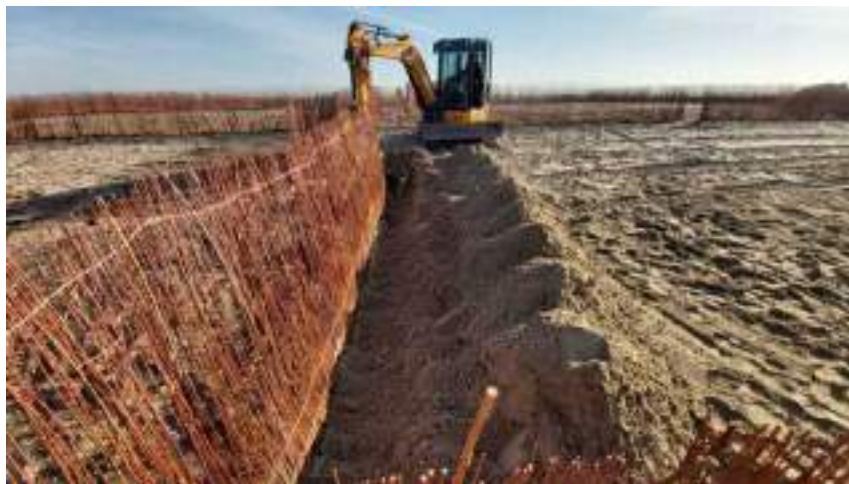
Imagen 85. Trabajos con maquinaria para la excavación de la zanja para la instalación de los captadores
