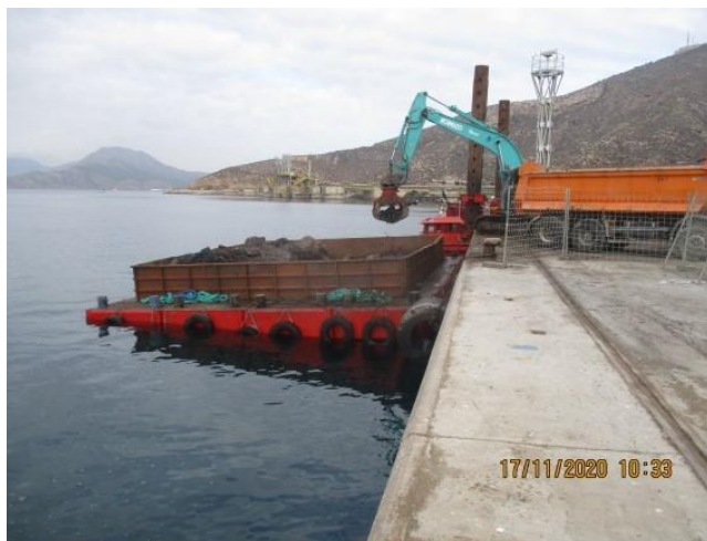
Figura 18 Descarga de cántara en tierra y carga sobre camión
