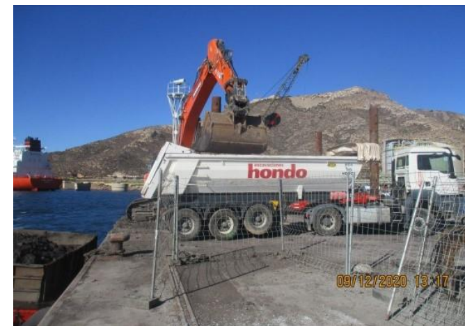
Figura 18 Descarga de cántara en tierra y carga sobre camión
