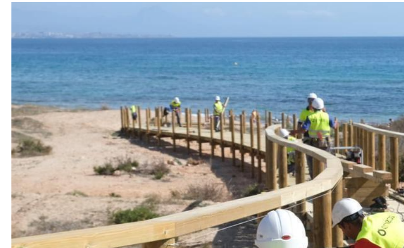
Figura 26. Montaje barandillas en pasarela elevada de madera
