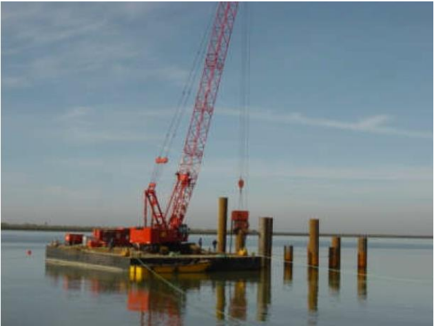
Figura 6. Extracción tablestacas mediante medios marítimos
