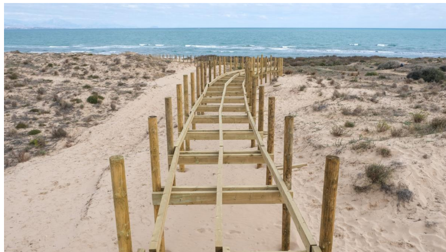
Figura 25. Instalación estructura pasarela elevada de madera
