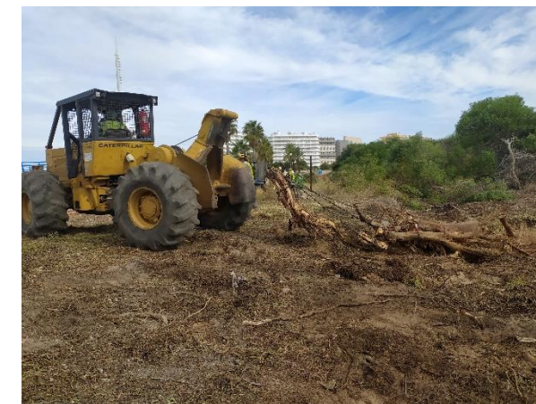
Figura 27. Skidder procediendo al destocoado
