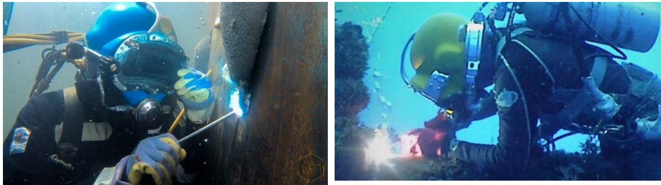
Figura 9. Trabajos de soldadura subacuática
