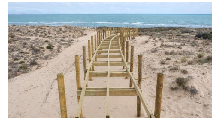
Figura 6. Instalación estructura pasarela elevada de madera
