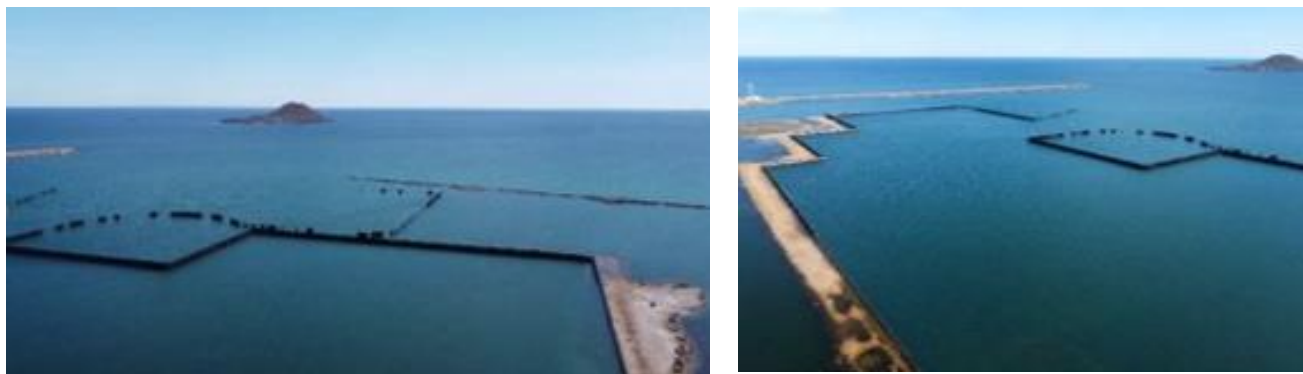
Figura 3 Tablestacado presente en el interior de la Caleta del Estacio
