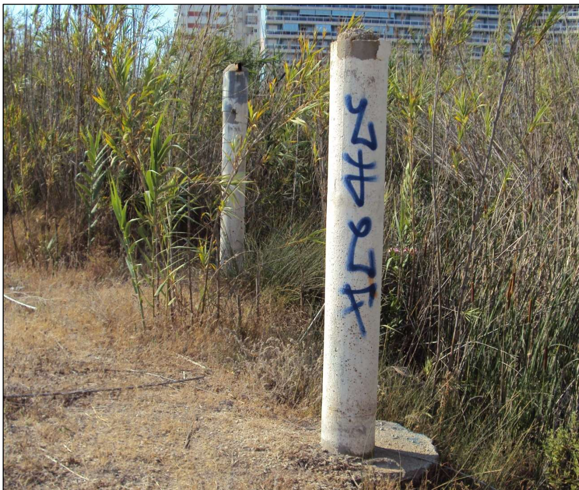
Punto fotográfico 5: Pilares de hormigón situados dentro del dominio público marítimo-terrestre.
