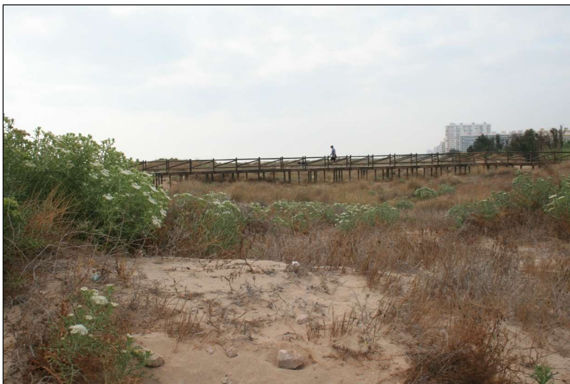
Punto fotográfico 6: Pasarela de acceso al mar desde la zona de aparcamiento.
