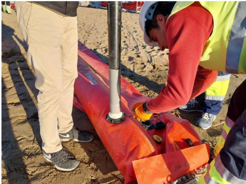
**Ilustración 28.** Inflado de barreras utilizando herramienta sopladora.
