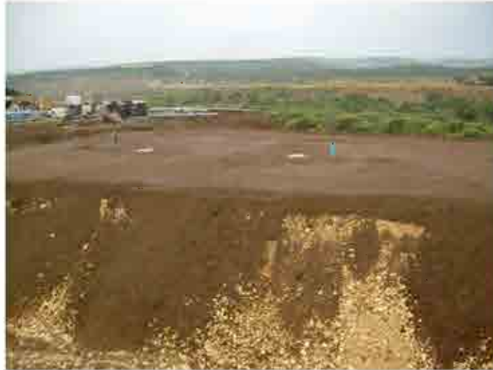
Fotografía 11. Finalización del terraplén de prueba A con la puesta en obra de tres tongadas. Se pueden observar las placas de asiento protegidas por tubería de pvc y los hitos de nivelación en superficie.
