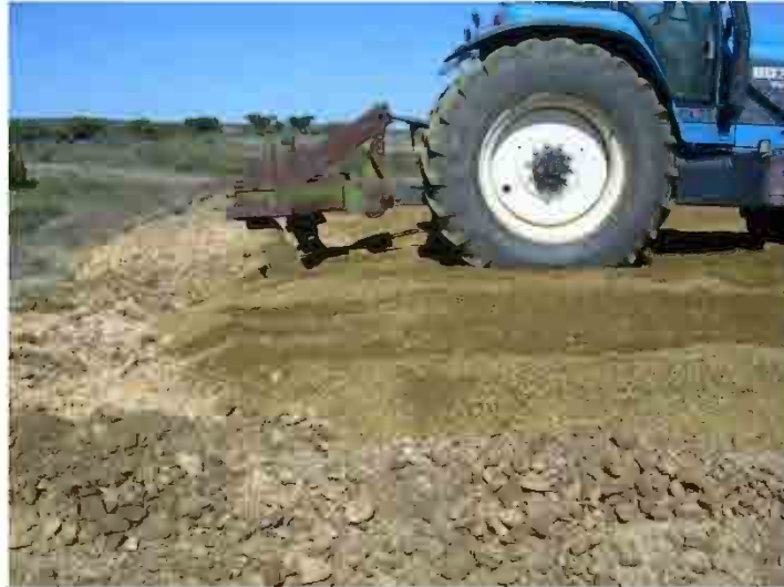
Fotografía 7. Mezcla de los materiales de torta y mineral agotado mediante ripper (Terraplén de prueba A- primera tongada).
