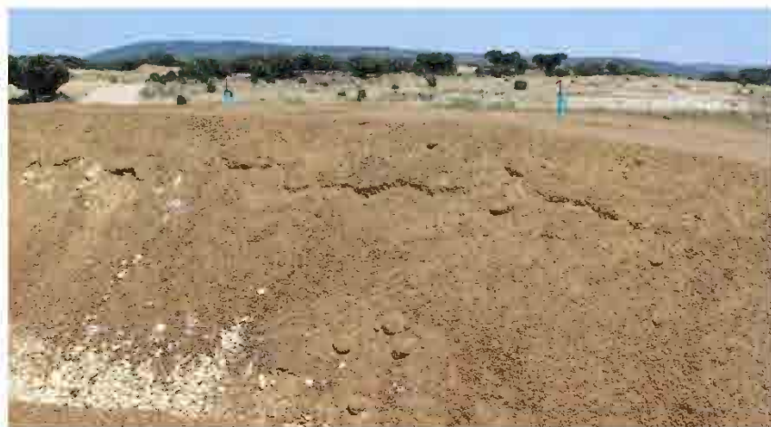
Fotografía 25. Desprendimiento longitudinal de tierras afectando al terraplén B (26-07-2018).
