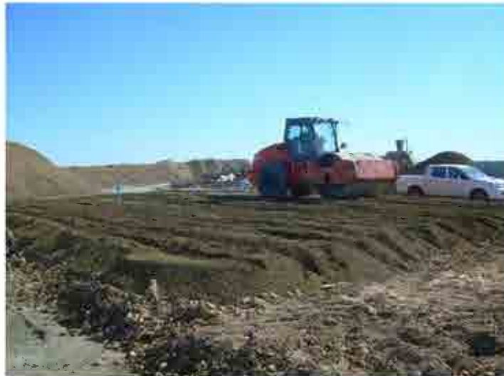
Fotografía 7. Mezcla de los materiales de torta y mineral agotado mediante ripper (Terraplén de prueba A- primera tongada).
