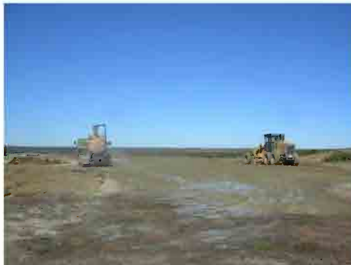
Fotografía 3. Nivelación y refinado de la superficie de mineral agotado mediante motoniveladora.
