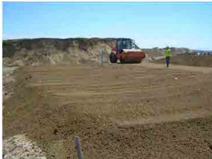
Fotografía 12. Finalización de la primera tongada formada por 30 cm de una capa de torta y dos capas de 25-30 cm de mineral agotado (Terraplén de prueba B).
