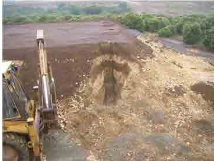
Fotografía 20. Calicata realizada en el talud del terraplén A.
