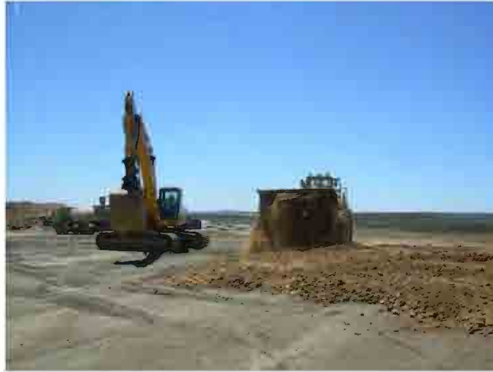
Fotografía 5. Vertido de los materiales de torta (Terraplén de prueba A – Primera tongada).
