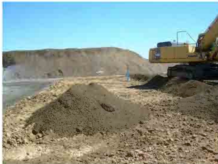
Fotografía 5. Vertido de los materiales de torta (Terraplén de prueba A – Primera tongada).
