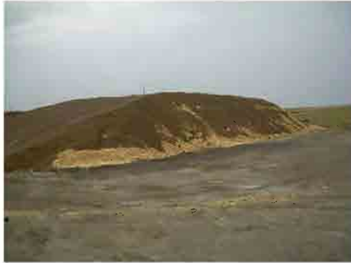
Fotografía 13. Terraplén de prueba B finalizado.
