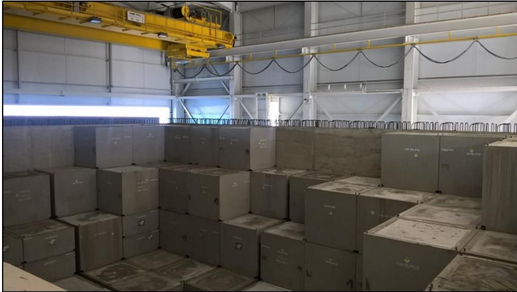
Figura 11. Celda de almacenamiento de RBMA
