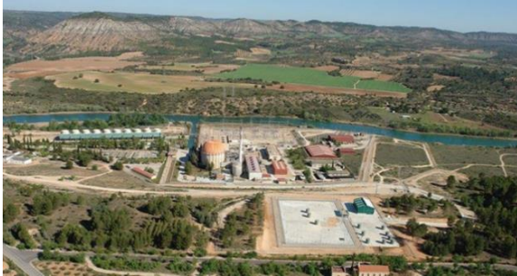
Figura 21. Aspecto del desmantelamiento de CN José Cabrera: antes y después (figurado) del desmantelamiento total
