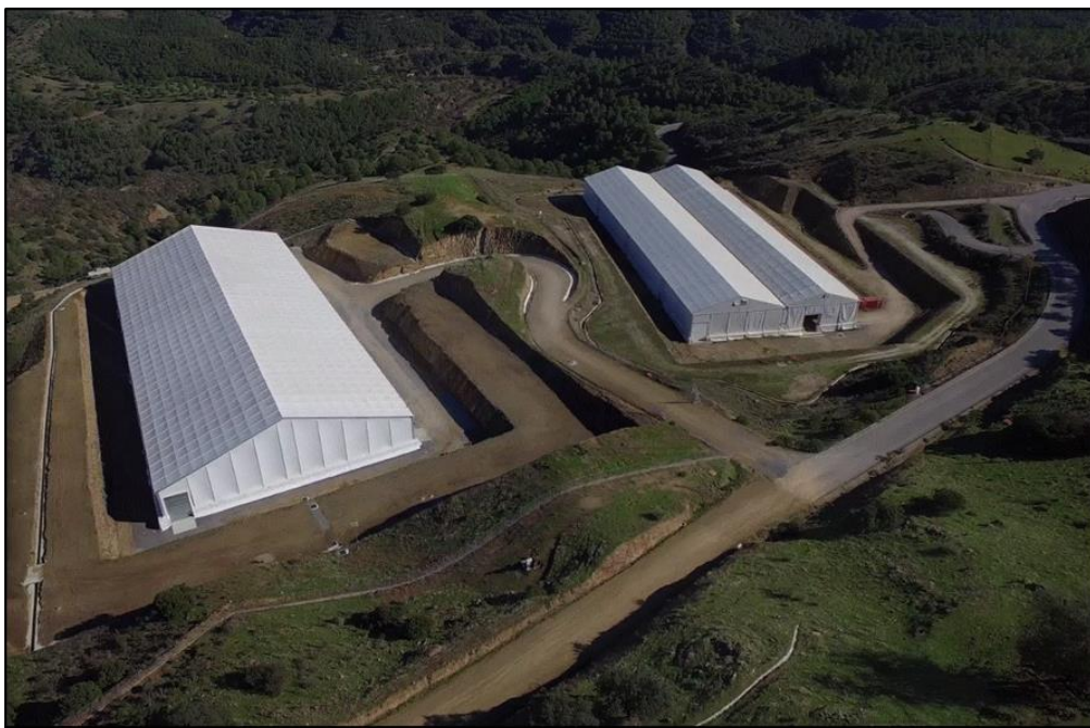
Figura 12. Instalación complementaria para el almacenamiento de RBBA
