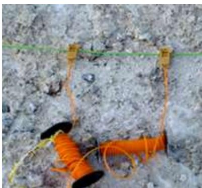
Figura 28: Conexión de detonadores electrónicos a la línea
