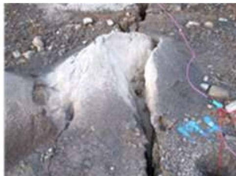
*Figura 76: Falta de movimiento tras la pega que indica la presencia de barrenos fallidos*
