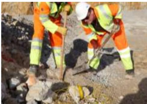
Figura 32: Conexiones enterradas en 20 cm de tierra o material de retacado
