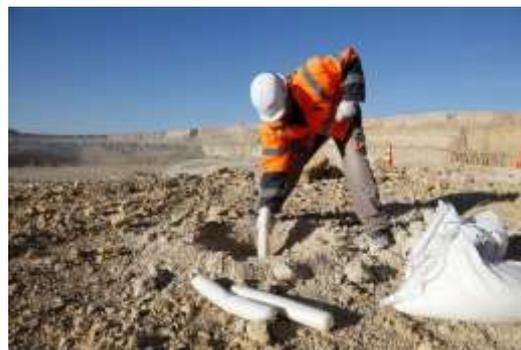
Figura 10: Carga de un cartucho de gel en un barreno
