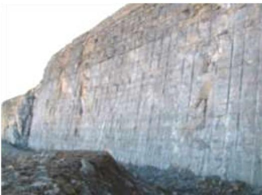
Figura 59: Talud final tras una pega de precorte
