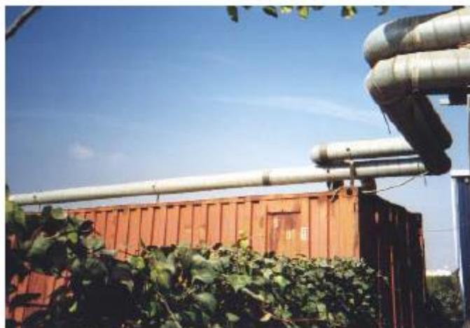
**Figura 32: Circuito cerrado tomando aire de la cámara de secado**
