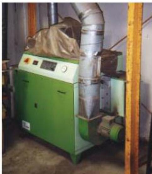
**Figura 31: Deshumificador de aire por rotor desecante (silicagel)**
