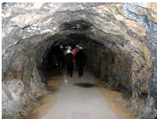
Sostenimiento natural en la Mina Museo de Almadén
