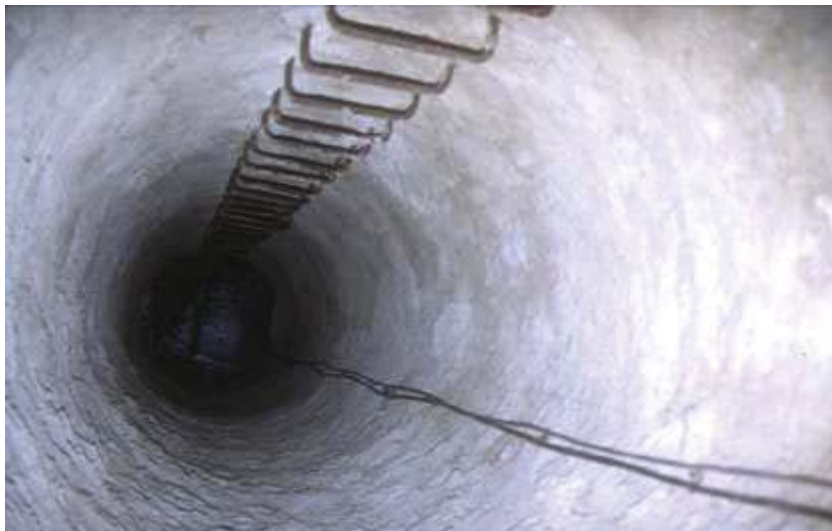
Pozo de comunicación vertical con escala en la Mina Museo de la Escuela de Minas de Madrid. Su consideración como salida de emergencia exigiría cierta capacidad de movilidad al visitante
