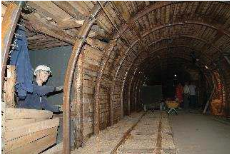
Ejemplo de vía de tránsito en solera de hormigón para paso de visitantes paralela a la vía original de ferrocarril en la mina museo de Escucha (Teruel)
