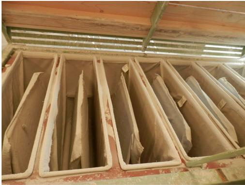
**Fig.** Filtros saturados debido a un mal mantenimiento, que pueden llegar a inutilizar el sistema o eliminar su eficacia. Esto, tanto en el caso de filtros para decantar polvo cuando se extrae aire mediante captaciones, como filtración de aire que se introduce en la nave. En todos los casos es fundamental contar con un plan de mantenimiento específico rigurosamente implantado.
