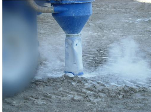
**Fig.** Captación de polvo de perforadora sin almacenamiento (y retirada) del residuo.
