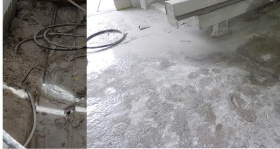
**Figs.** Acumulación de polvo consecuencia de drenaje inadecuado y malas prácticas en limpieza. **Esto puede anular la eficacia de los mejores métodos de prevención que tenga instalada la empresa.**
