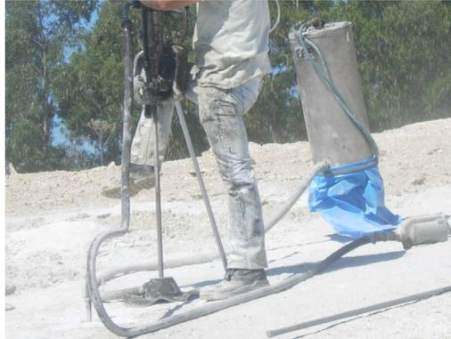
**Fig.** Perforación manual con captación
