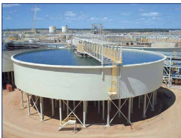
Ilustración 6-90 Cimentaciones Tanque Espesador
