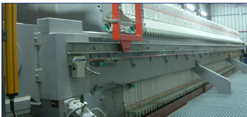
Ilustración 6-99 Parada De Emergencia Por Cable
