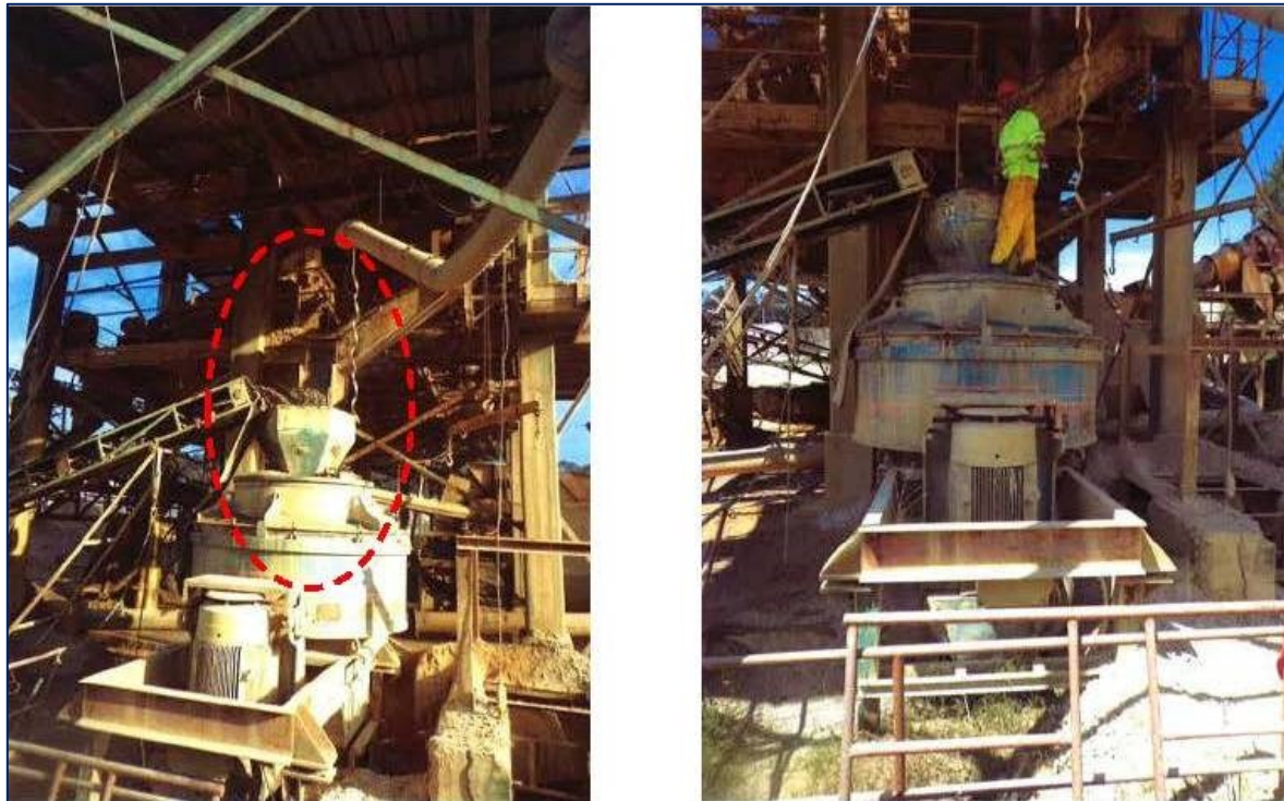
Ilustración 7-13 Vistas Lugar Del Accidente Trituración Secundaria
