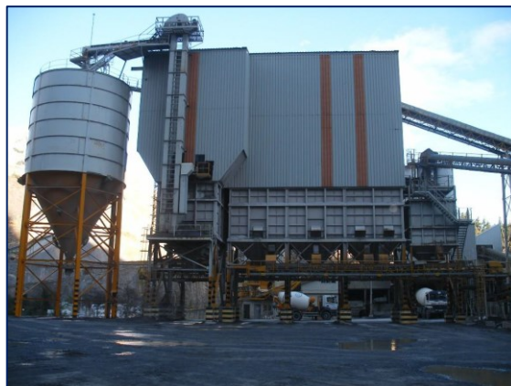
Ilustración 6-78 Silo Anexo A Línea De Tolvas Expendedoras
