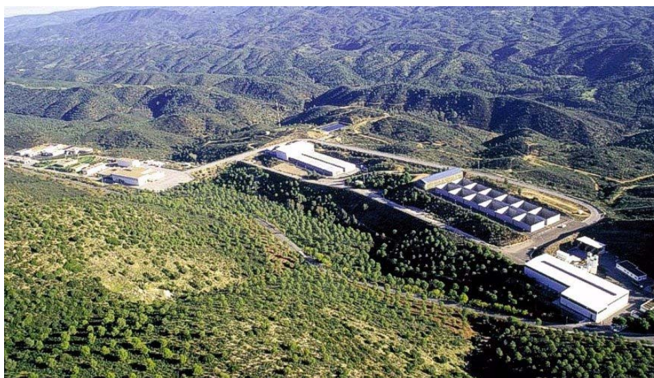
FIGURA 5. EL CABRIL (VISTA AÉREA DE LA INSTALACIÓN)
