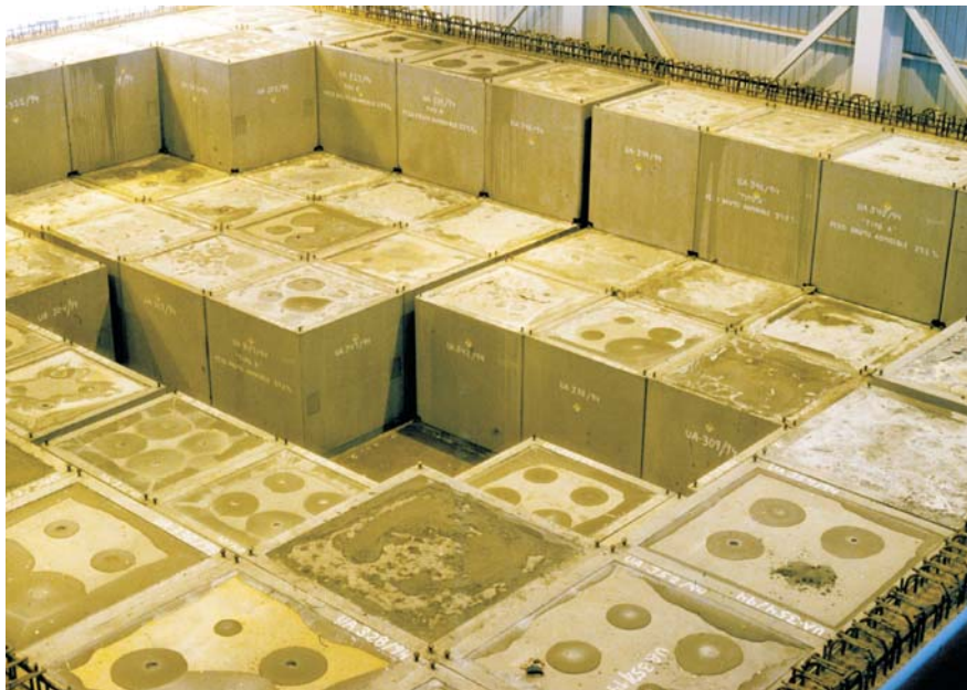
Instalaciones de gestión de residuos radiactivos: disposición final de contenedores en celdas (El Cabril).
