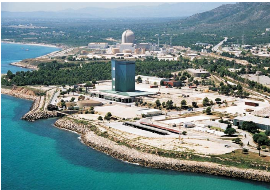
Instalaciones en fase de clausura: C.N. Vandellós I.
