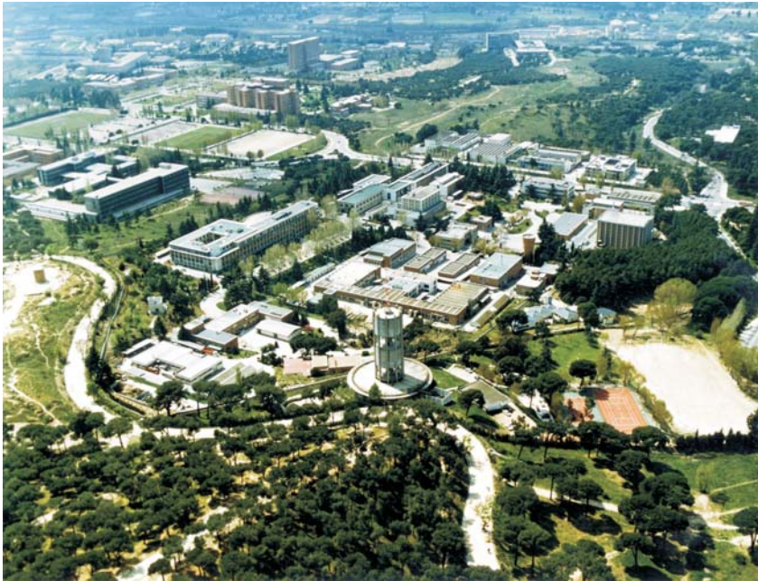
Instalaciones en fase de clausura: vista aérea del CIEMAT (Madrid).
