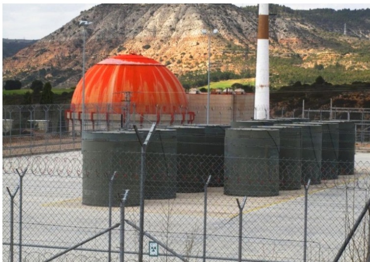
Figura 5. Vista de ATI de la Central Nuclear de José Cabrera.
