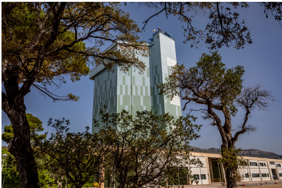
Vista de la instalación que protege el cajón del reactor de la Central Nuclear Vandellós I.
