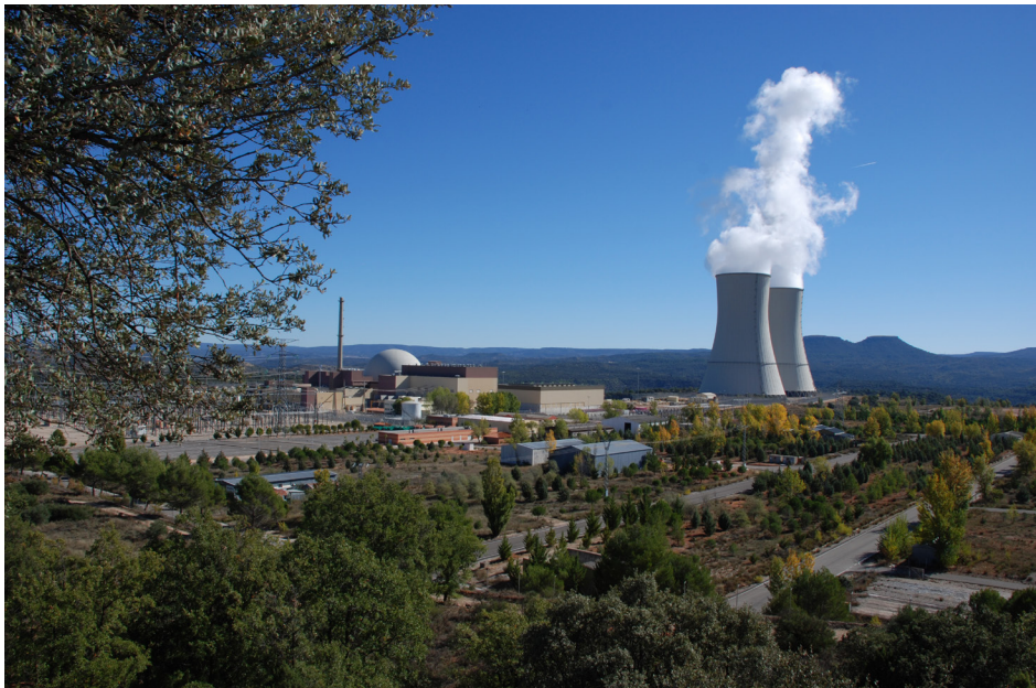
Vista general de la Central Nuclear Trillo.
