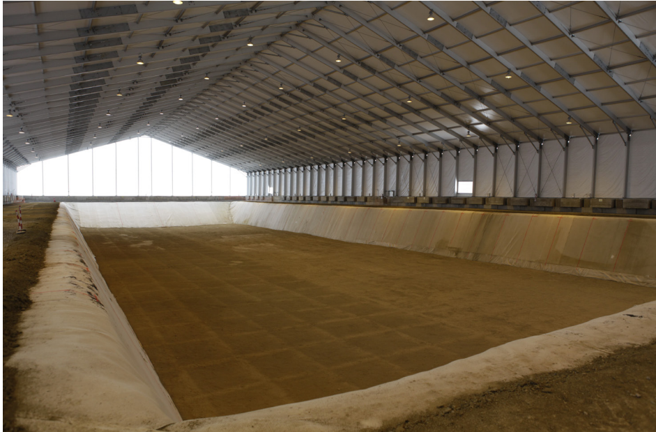
Imagen del interior de la celda de almacenamiento de RBBA en El Cabril.
