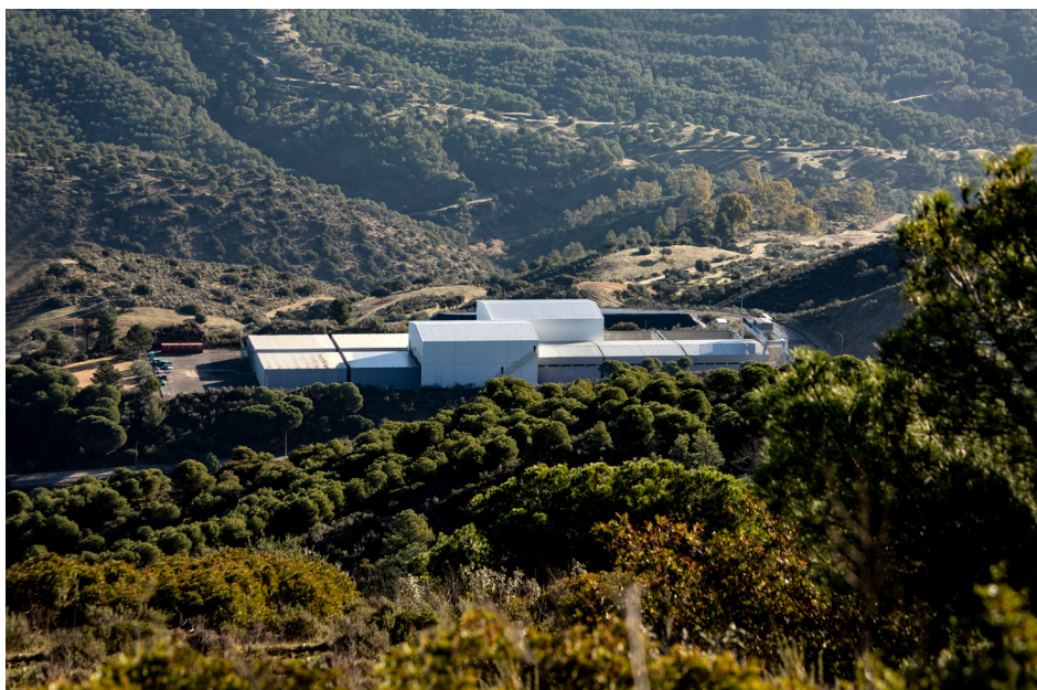
Vista de las celdas de almacenamiento definitivo de RBMA de la Plataforma sur del C.A. El Cabril.
