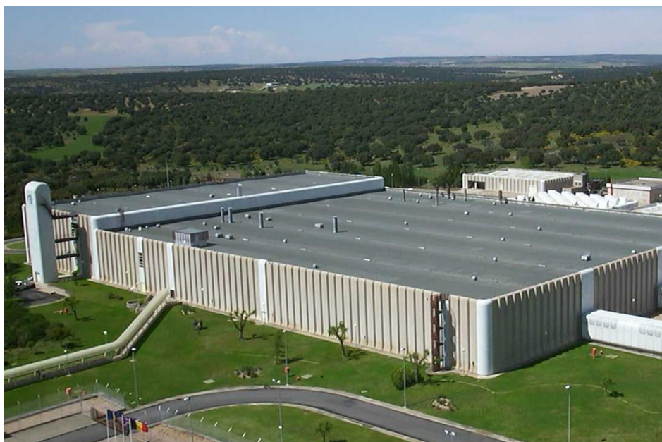
Vista de la Fábrica de elementos combustibles de Juzbado (Salamanca).
