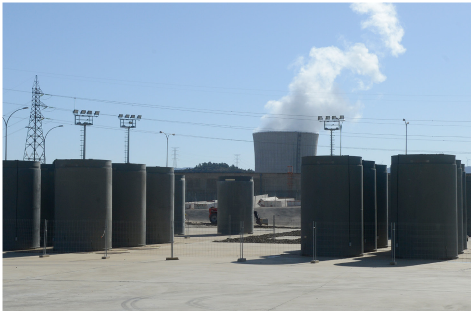
Vista del ATI de la Central Nuclear Ascó.
