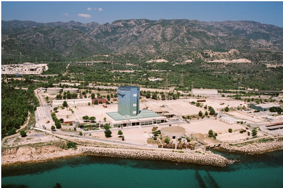
Imagen de la Central Nuclear Vandellós I, actualmente en periodo de latencia.
