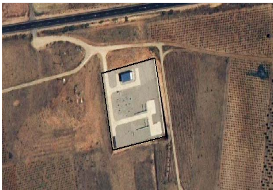
Figura 1: Estación de Regulación y Medida
