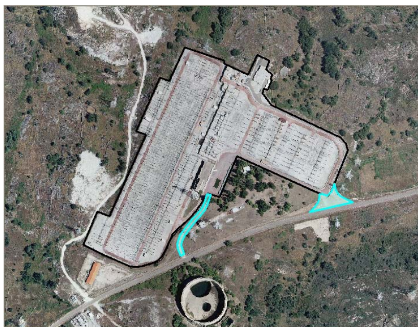
Figura 12: Ejemplo de acceso a una subestación
