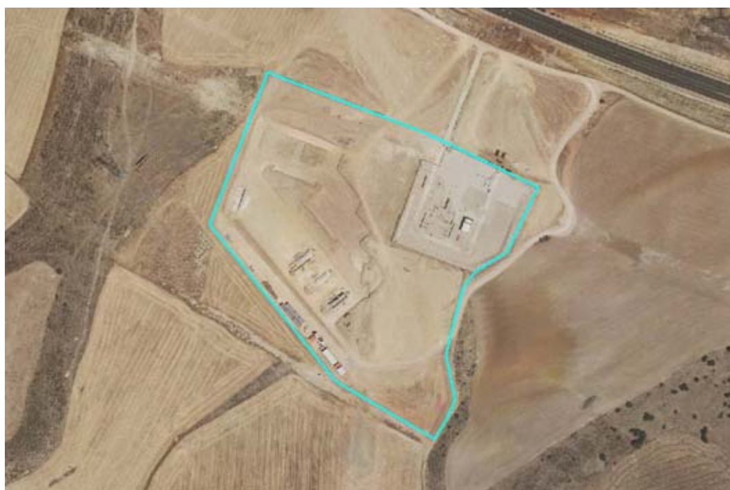
Figura 4: Estación de Compresión de Chinchilla
