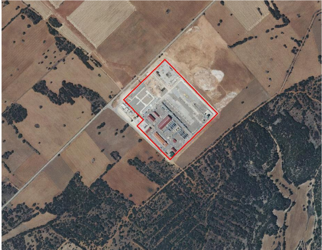
Figura 5: Planta de almacenamiento de Yela (Guadalajara)
