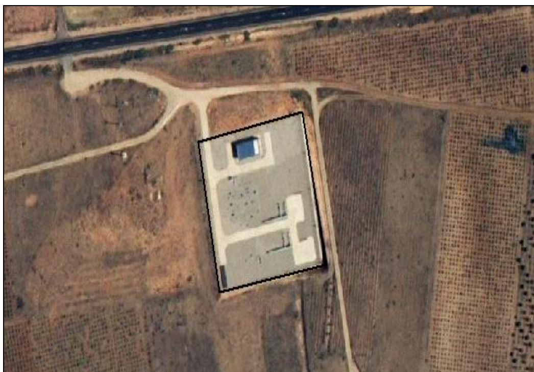
Figura 1: Estación de Regulación y Medida
