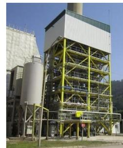
Ilustración 41: Planta piloto de captura de CO<sub>2</sub> de la CTLP.
