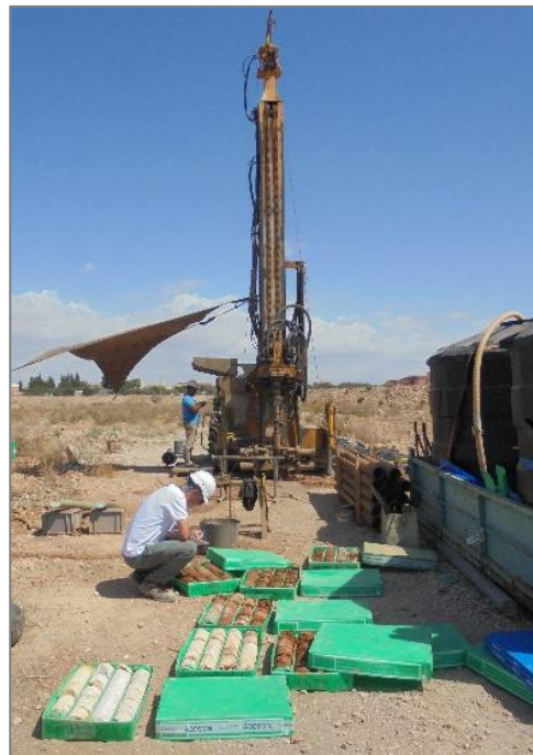
Figura 26. Imágenes de la construcción de los sondeos litológicos.
