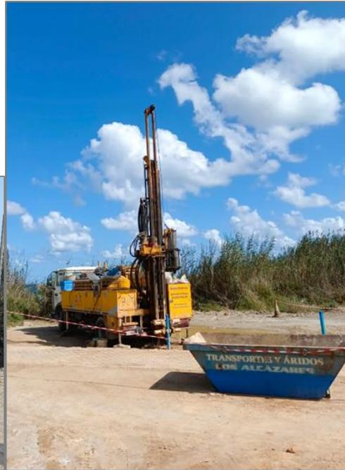
*Figura 41. Construcción de los nidos de piezómetros en el humedal de La Hita.*
