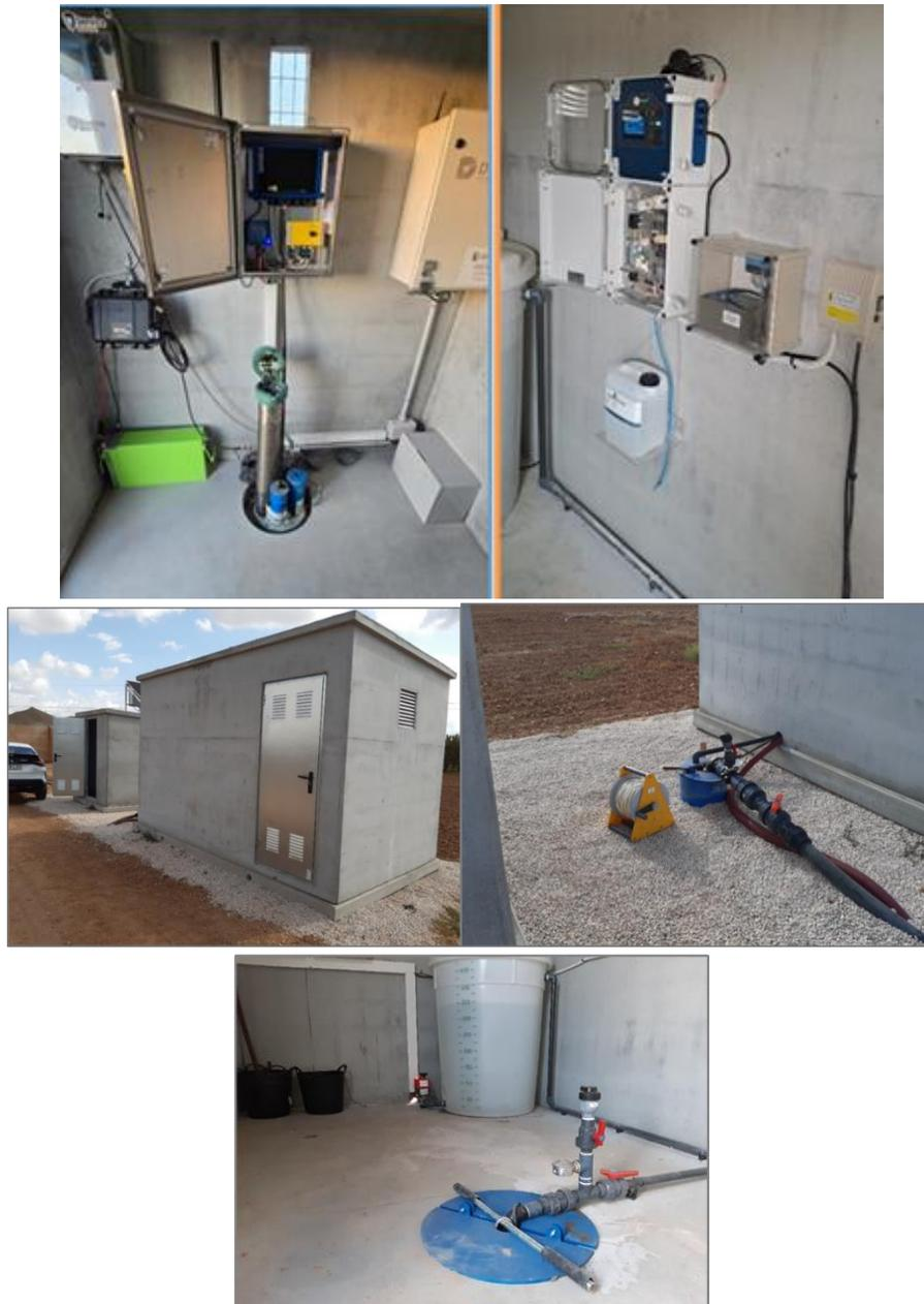
Figura 42. Sondeos y equipos de medida. Arriba izqda.: sondeo con sondas de medida de nitratos en continuo instalada; arriba dcha.: mini laboratorios portátiles; centro izqdo.: vista exterior de las casetas en cuyo interior se ubican los sondeos y equipos de medida; centro dcho.: pozo de bombeo para movilizar las aguas del acuífero de manera previa a las mediciones; abajo: sondeo de extracción y depósito de recogida del agua de los minilaboratorios.
