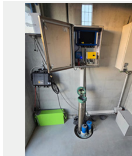
Fig. Sondeo con sonda de medida de nitratos en continuo instalada.
