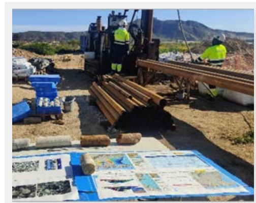
Fig. Construcción de los sondeos.
