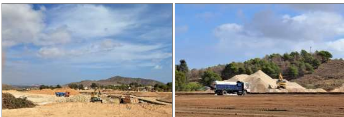
Figura 30. Avance de las obras en el Conjunto 1. Llano del Beal.
