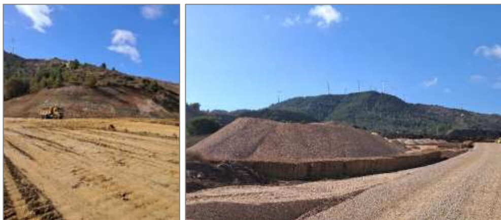
Figura 31. Avance de las obras del Conjunto 5. Descargador.
