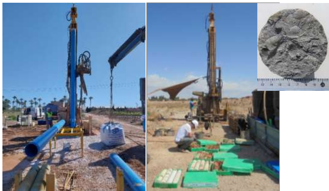
Figura 50. Imágenes de la construcción de los sondeos. Detalle de fósiles encontrados en los materiales perforados
