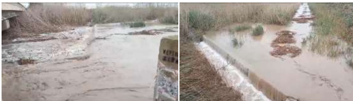
Figura 22. Imágenes de la crecida de las lluvias de marzo en la desembocadura de la rambla del Albuñón.
