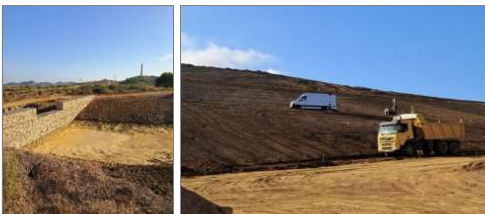
Figura 32. Avance de las obras en el Conjunto 4. Brunita.
