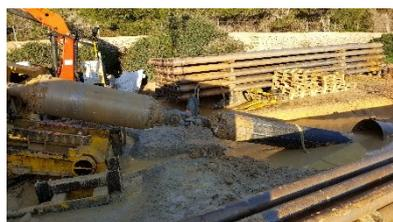
Salida del tubo por el inicio de la perforación.
