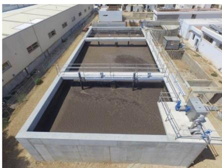
*Digestor aerobio y tamizado*
