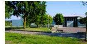
ABETXUKO Potencia Instalada: 500 kW
