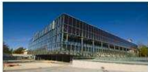
MENDIZORROTZA Potencia Instalada: 200 kW
