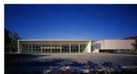
SAN ANDRES Potencia Instalada: 200 kW
