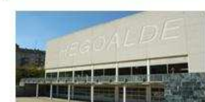
HEGOALDE Potencia Instalada: 250 kW
