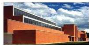
LAKUA Potencia Instalada: 250 kW
