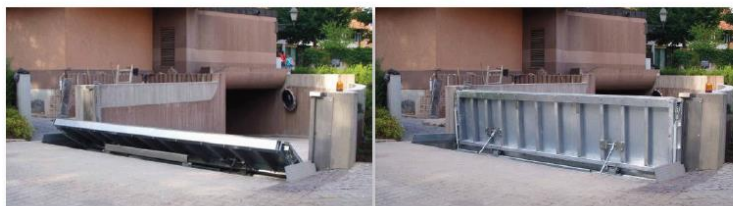
Figura 40. Puertas de cierre estancas modulares que ofrecen solución de continuidad al muro de cierre, montadas dentro de dos perfiles en U ancladas en una pared. Es posible instalar postes intermedios en áreas más grandes. Fuente: izq.: Aggères. Dcha.: Ryst.
